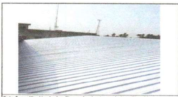
Foto 5: sustitución de duralita por lamina troquelada calibre 26 y mantenimiento de soporte de metal
