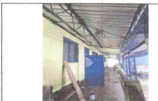
Foto 4: sustitución de duralita por lamina troquelada calibre 26 y mantenimiento de soporte de metal
