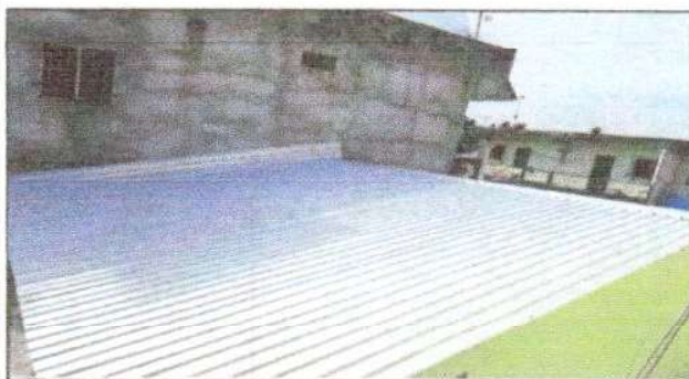
Foto 3: sustitución de duralita por lamina troquelada calibre 26 y mantenimiento de soporte de metal
