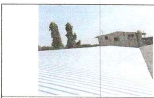
Foto 6: sustitución de duralita por lamina troquelada calibre 26 y mantenimiento de soporte de metal
